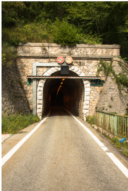
Tunnel du tramway
