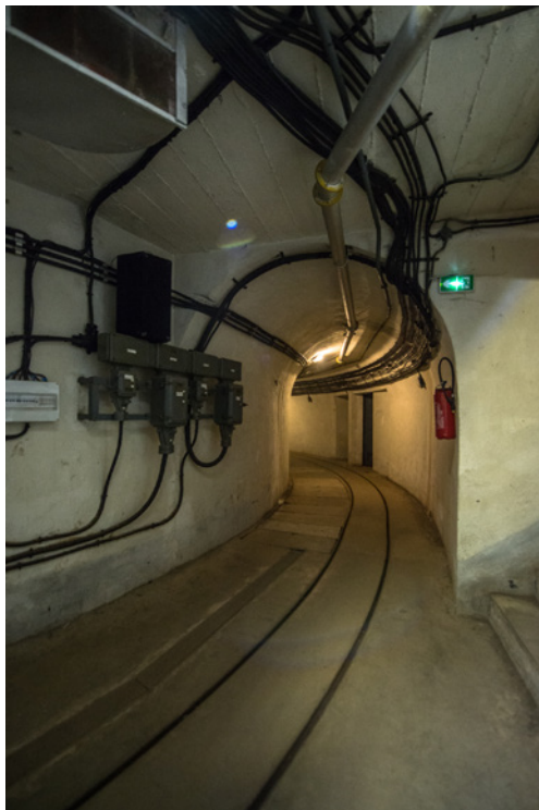
Galerie principale de l'ouvrage
