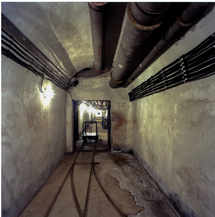
Galerie de l'ouvrage du Barbonnet
