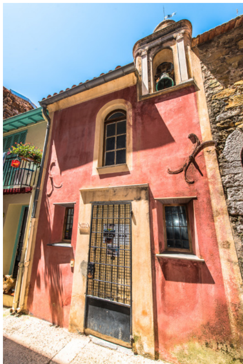
Chapelle de la Miséricorde, 5 bis, rue du général Sarraill
