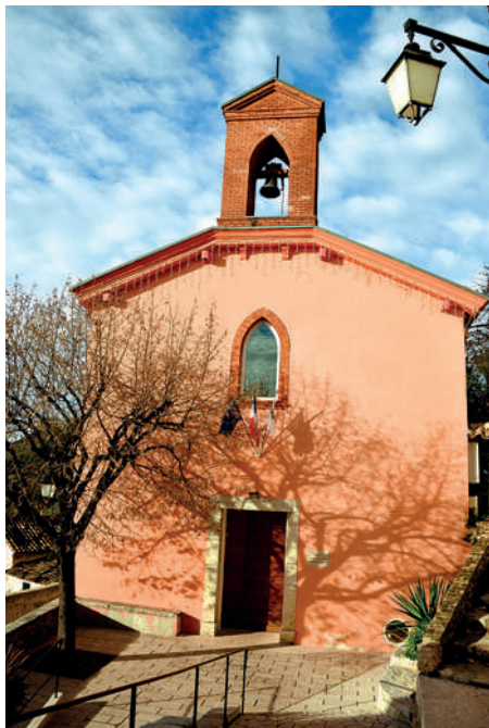
Façade de la chapelle
