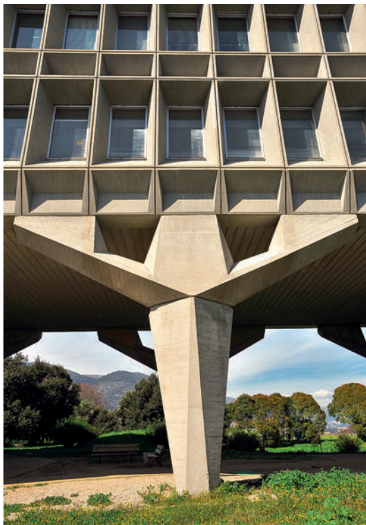
Le bâtiment et ses pilotis
