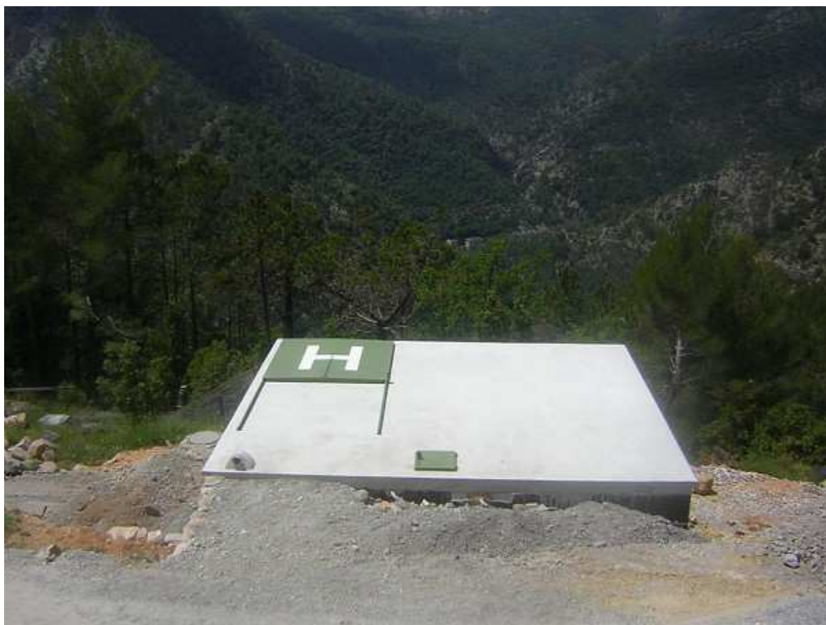
Figure 3 : Exemple de bassin maçonné à vocation DFCI avec une trappe pour les HBE
