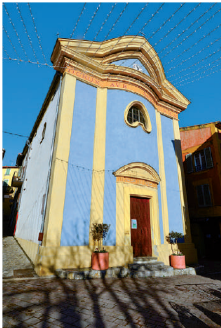
Façade de la chapelle Sainte-Croix
