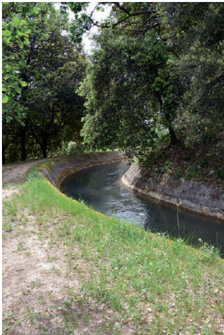
Section du canal à ciel ouvert
