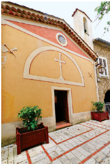
Façade de la chapelle Sainte-Croix
