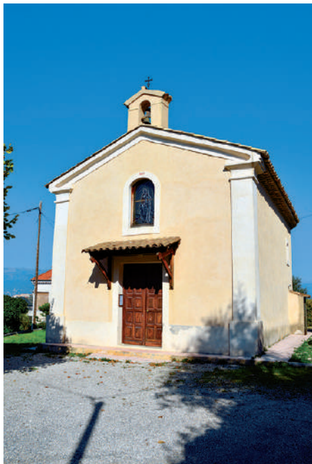
Chapelle Saint-Roch, façade
